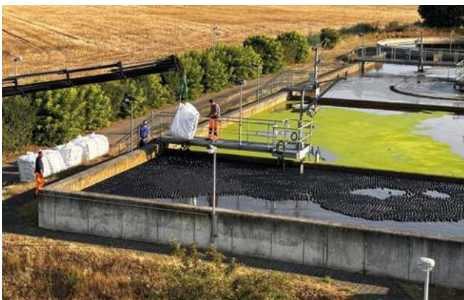
Abb. 2: Einbringen der Schwimmbälle
