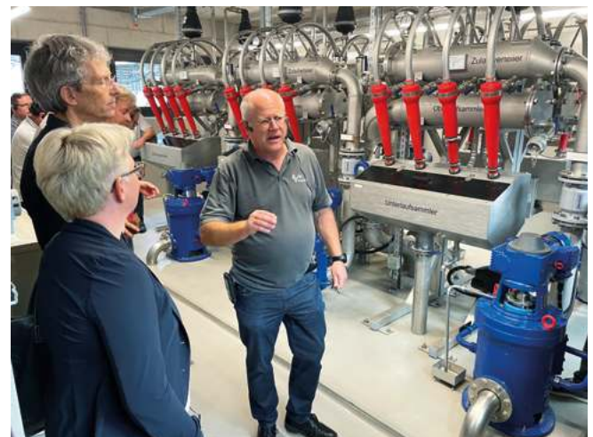
Roland Boller erklärt die Zyklone zur Abscheidung der Granulen.
