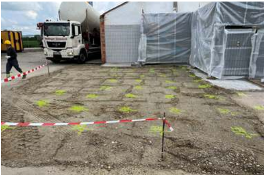
Abb. 1: Unter den Gewebeplanen sind die alte Rechenanlage und der Sandklassierer in Betrieb, die Injektionspunkte sind auf der abgeräumten Baufläche angezeichnet.
