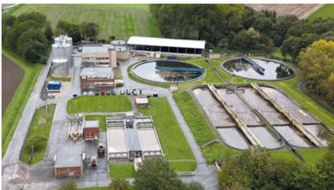
Abb. 1: Kläranlage Barsinghausen mit einer Ausbaugröße von 67 000 EW
