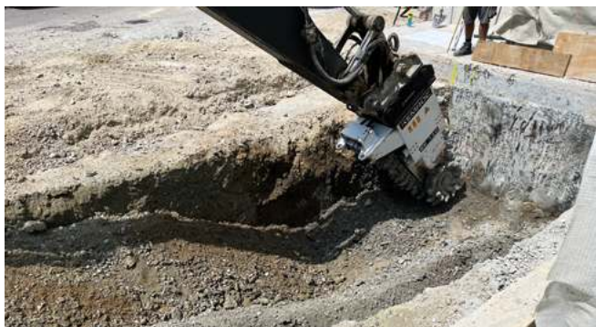
Abb. 2: Mit der am Bagger montierten Fräse wird der stabilisierte Baugrund für den Aushub gelockert.
