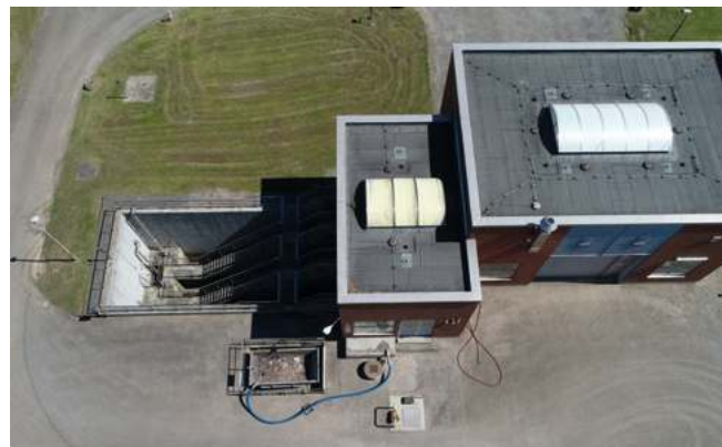
Abb. 2: Dort wo der blaue Schlauch liegt, steht der Entwässerungscontainer, in dem das Fett gelagert und entwässert wurde. Nach Vollfüllung des Containers wurde dieser zur thermischen Behandlung abgefahren.
