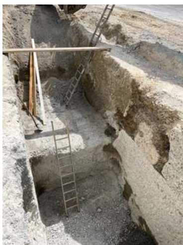
Abb. 3: Dank der Injektion bleiben die Baugrubenwände stehen, und die Baugrube kann passgenau hergestellt werden.
