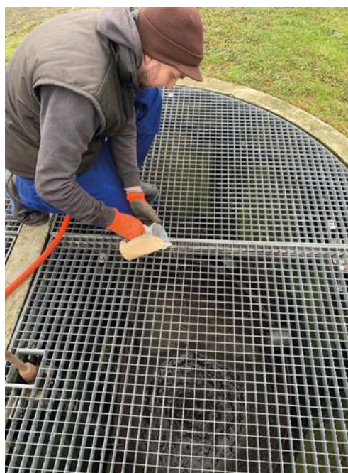
Abb. 5: Zugabe des verdünnten Produkts. Falls Restwasser im Fettschacht vorhanden ist, kann das Produkt direkt zugegeben werden.
