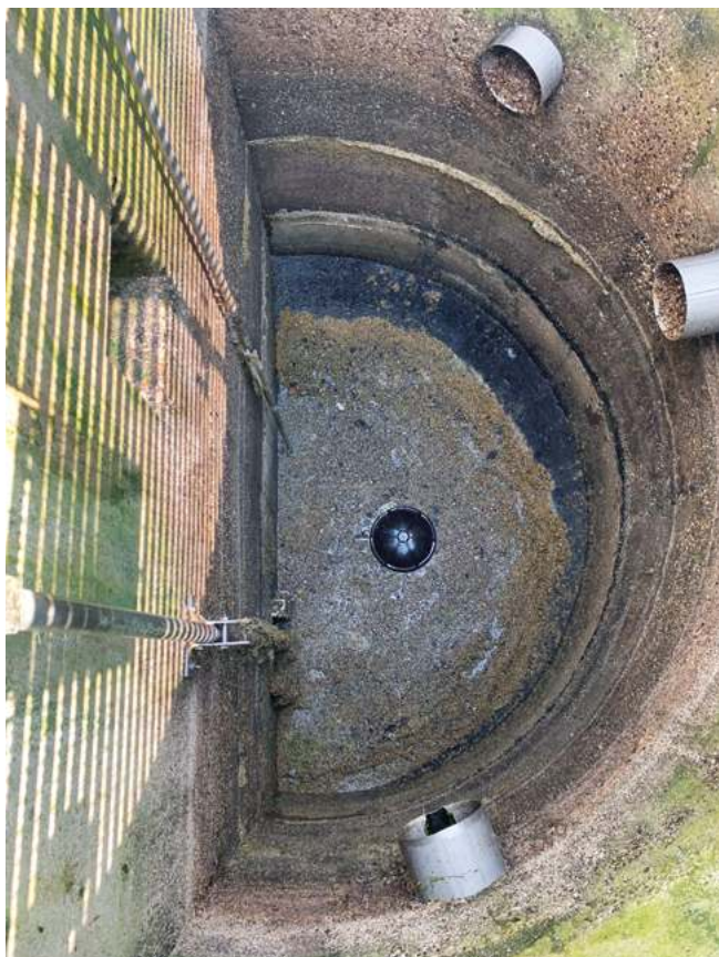
Abb. 3: Einbau Belüfterteller im Fettschacht mit einem Anschluss an die Luftleitung vom Sandfang
