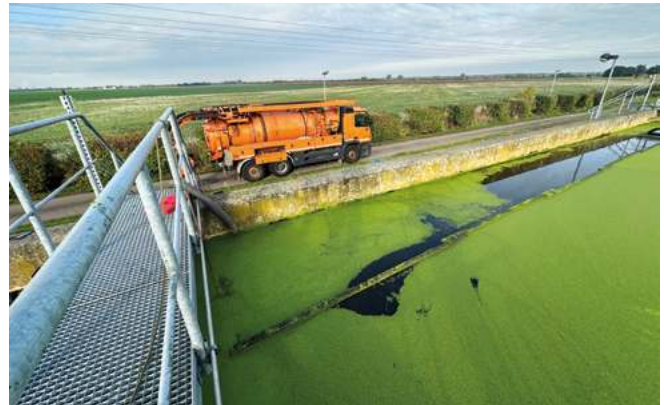
Abb. 1: Der Wasserlinsenteppich muss mit Saugwagen aufwendig entfernt werden.
