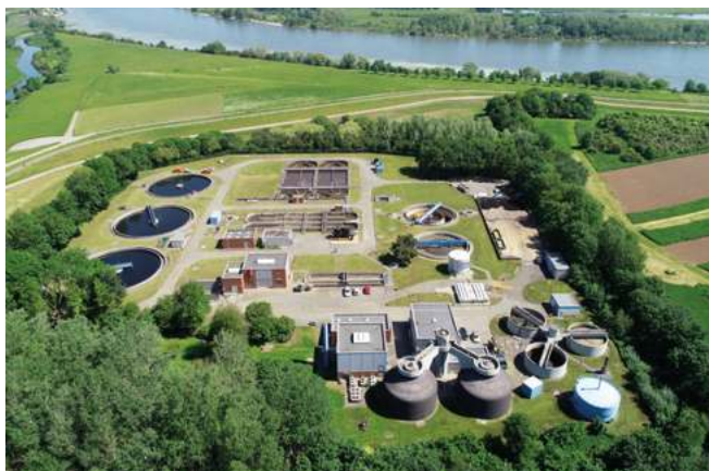
Abb. 1: Die zentrale Kläranlage Rheinberg mit einer Ausbaugröße von 83 000 EW
